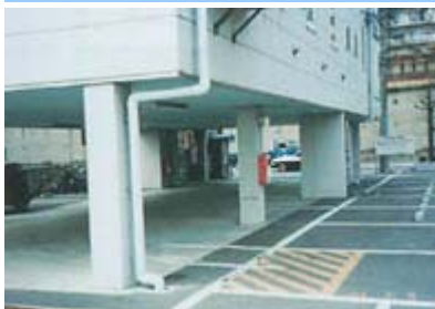
対象構造物の1階駐車場部分。
