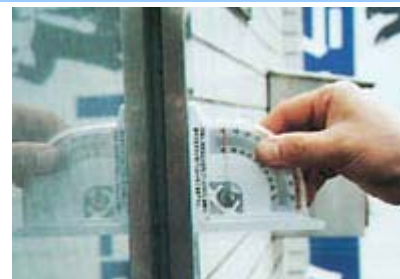
傾斜の被害は認められない。
