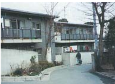
3棟が階段状に並んでいる。
